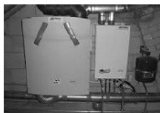
Afbeelding 2 installatie voor balansventilatie
